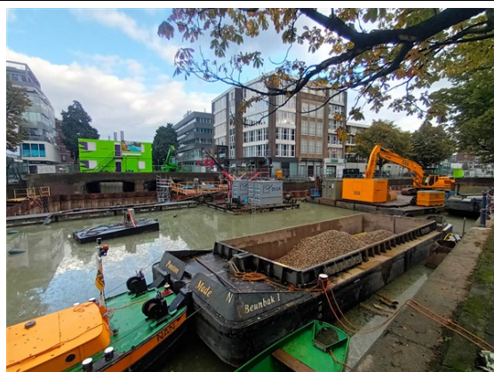
圖 2 鹿特丹運河衝浪設施工地
